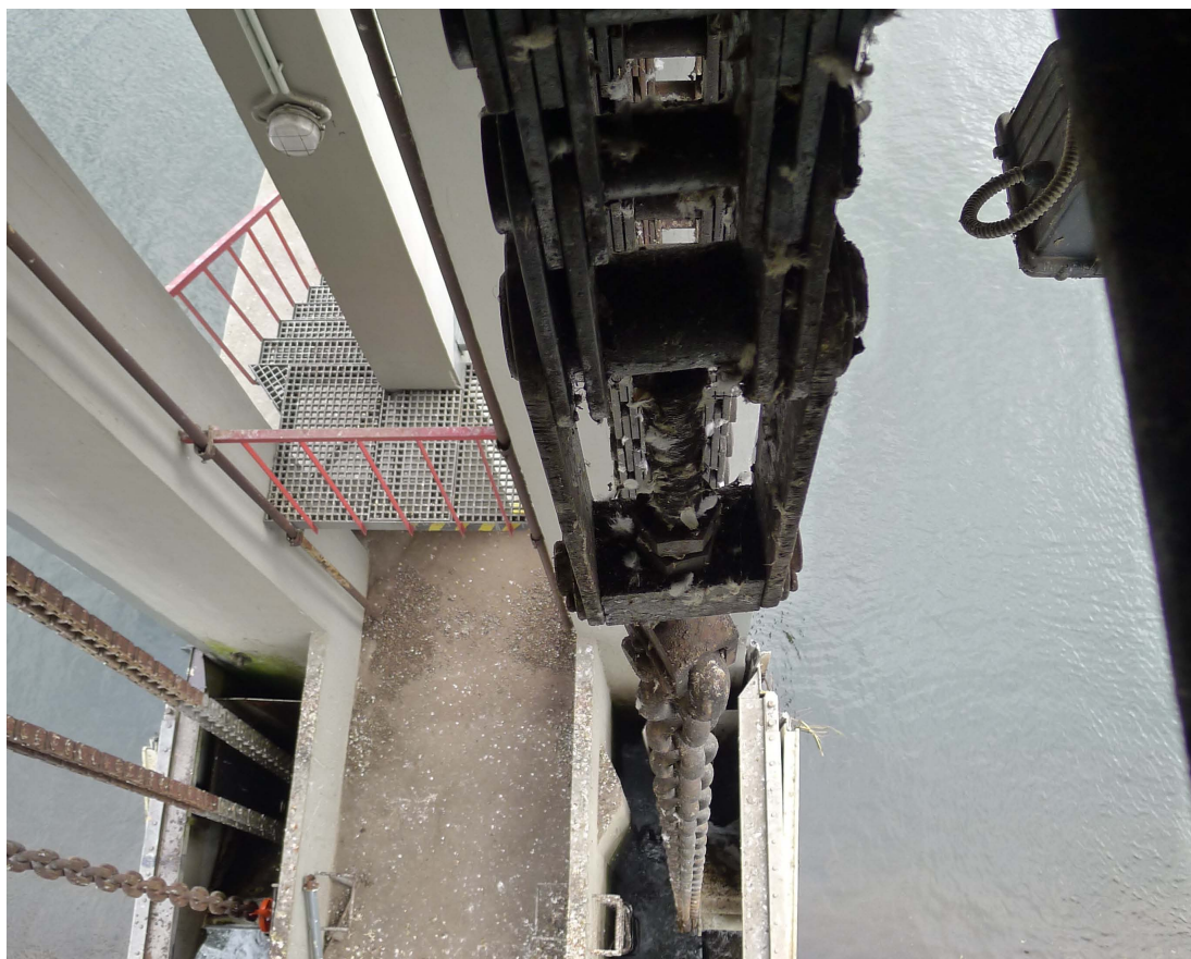
Regulační napínák horního závěsu článkového řetězu
